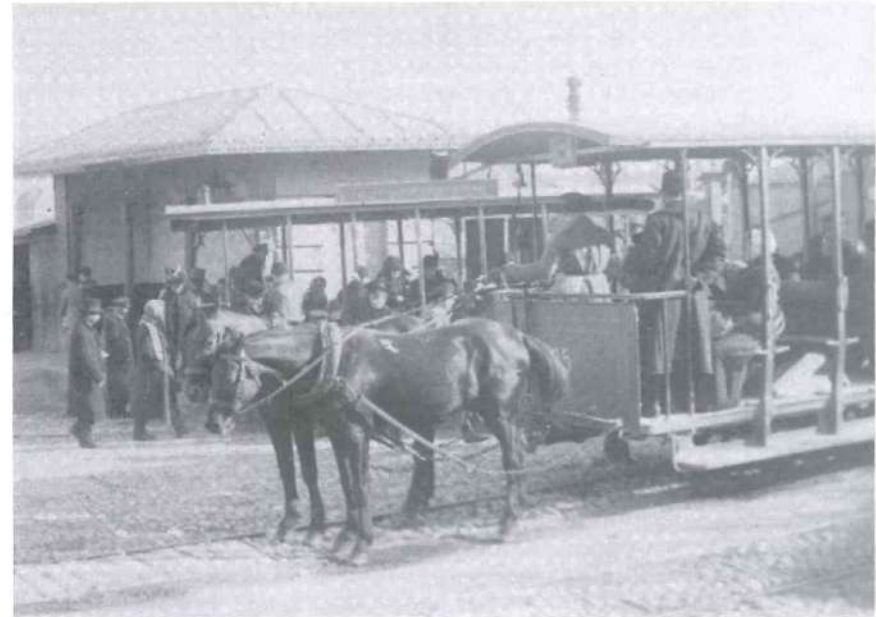
Станция конки у Верийского моста
