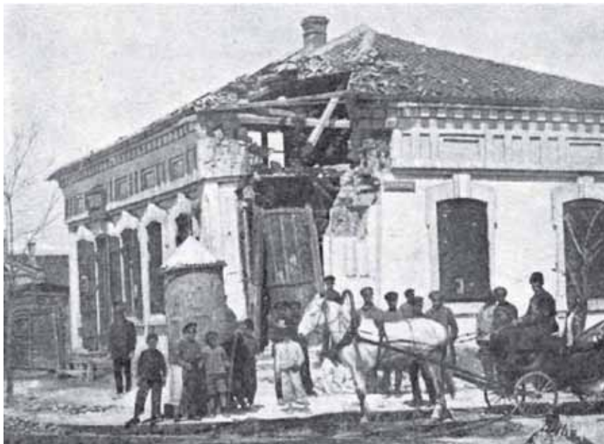
Дом, поврежденный при обстреле Бердянска с моря
